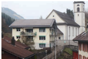
Das Pfarrhaus vor der Kirche Flühli mit dem Fotovoltaikdach. Bild: zvg
