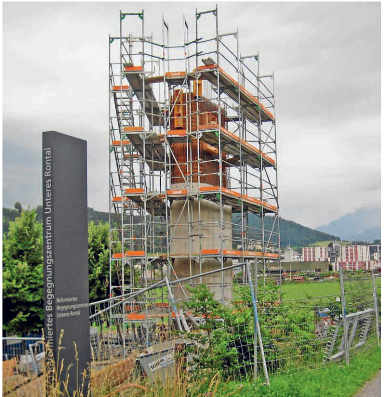
Unten: Stand der Bauarbeiten beim Glockenturm am 17. Juni. (Foto: W. Willi)
